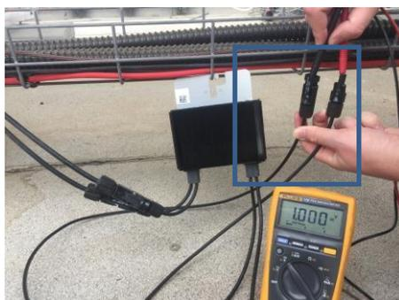
Se  $V_{out} < 0.6V$  → Substituir Otimizador
